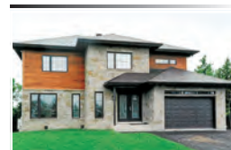
FINALISTE CONSTRUCTION MAURICE BILODEAU INC. 418 831-4024
