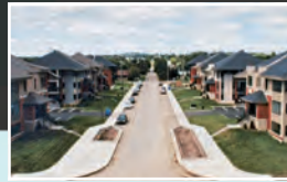
FINALISTE CONSTRUCTION S.M.B. INC. 418 872-7734
